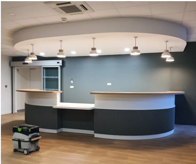
Fabrication d'une banque d'accueil en CP cintrable, stratifié blanc et panneau orac.
