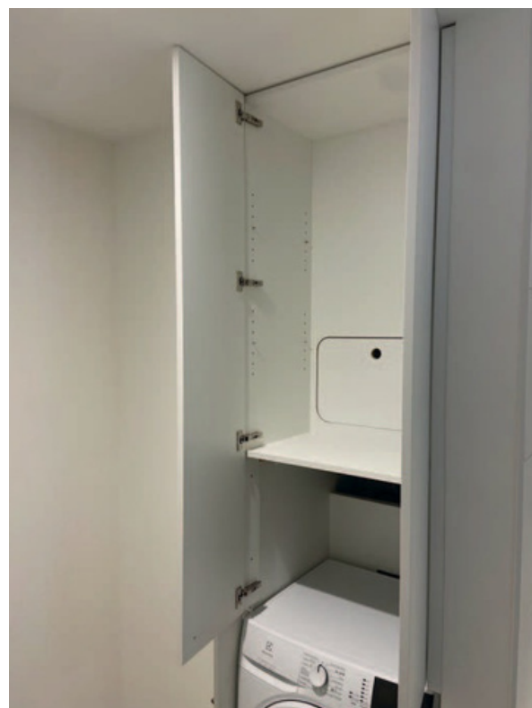
Fabrication et pose d'un placard de rangement avec trappe technique. Fabrication avec CN Felder 950.
