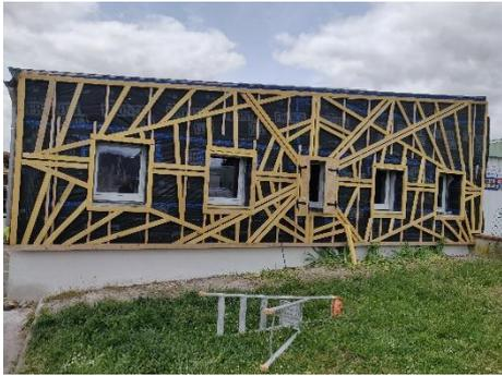
réalisation d'une ossature en façade pour insérer l'isolation bio sourcé en laine de bois, pose du pare pluie et latte de ventilation, débit et pose des lattes support du bardage décor.
