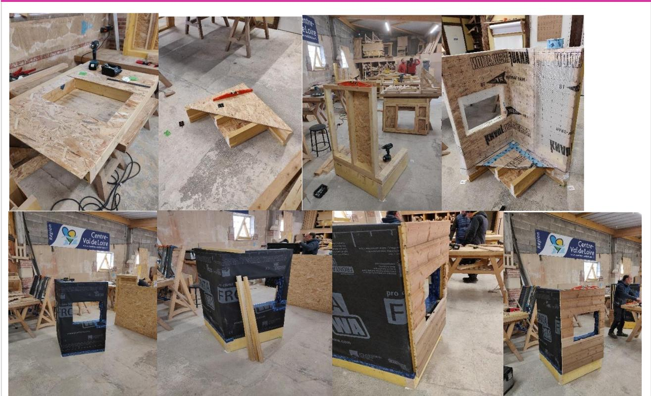
Construction du plancher, deux murs, contreventement, pare vapeur, pare pluie
