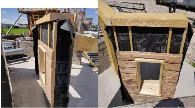
Débit et montage d'ossature de murs d'angles
