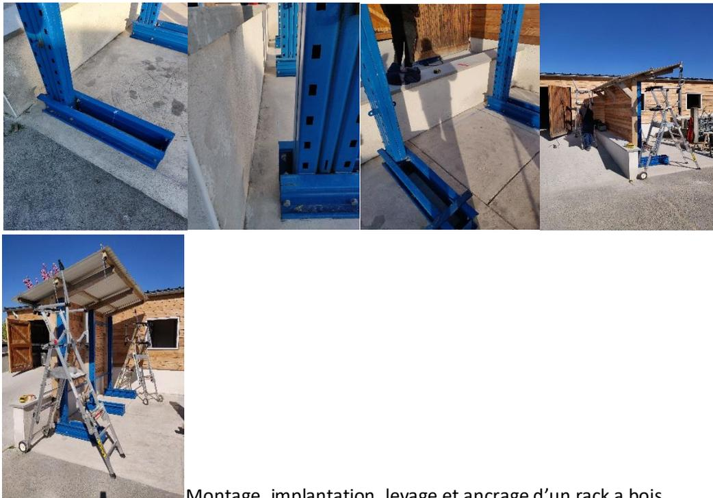
Montage, implantation, levage et ancrage d'un rack a bois.
