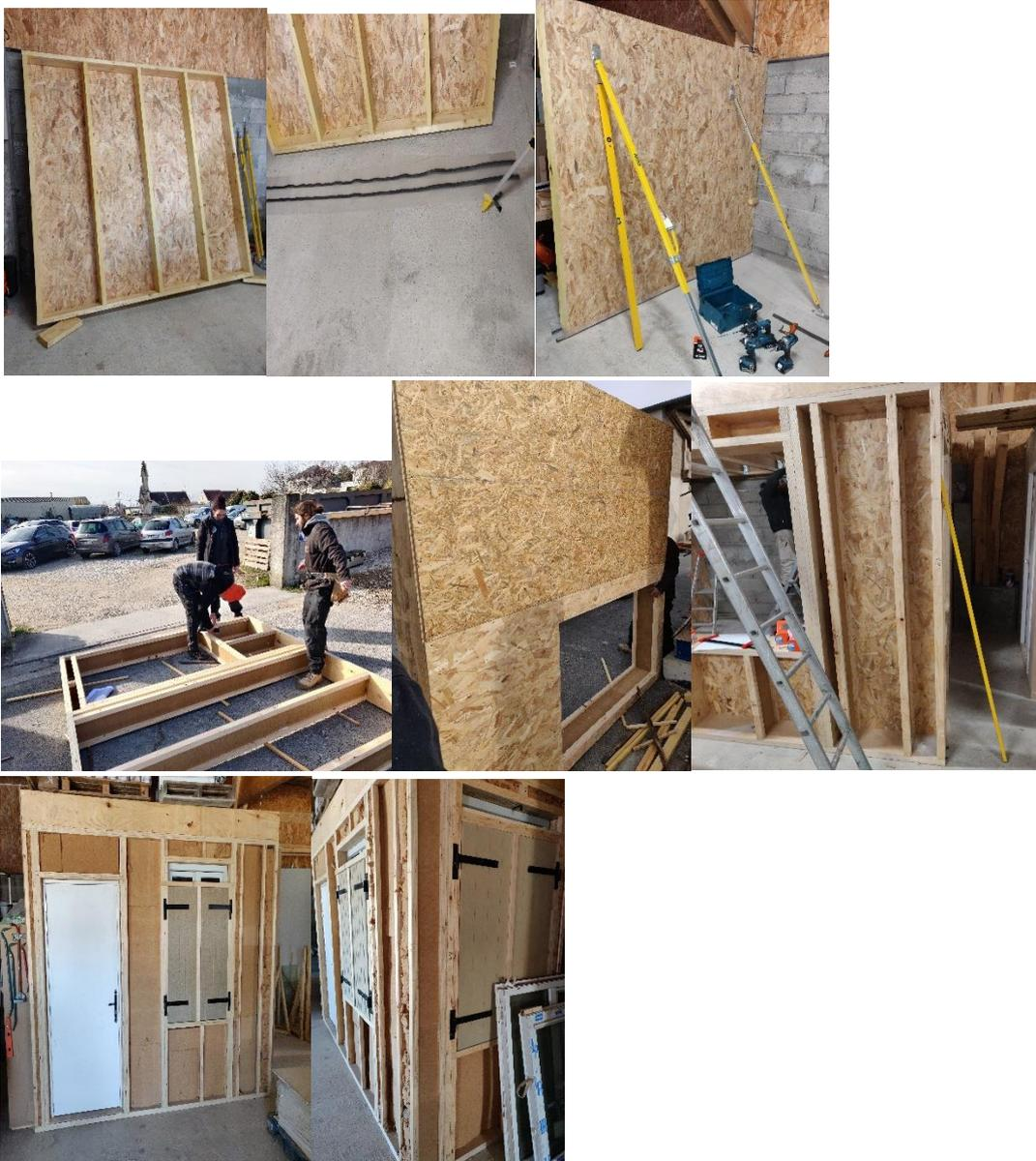
Construction de murs d'ossature en bois massif, lamellé/collé, et poutre en I, contreventé, levé, ancré, puis isolé.
