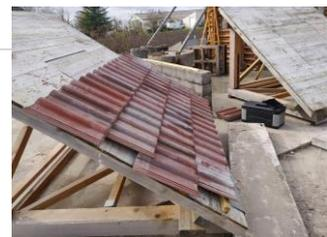
Travail de couverture, sur pan de toit, pose de lattes et tuiles diverses.
