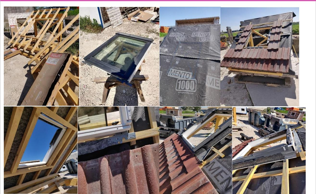
Pose de latte et ouverture d'une trémie accueillant une fenêtre de toit velux et ses abergements.
