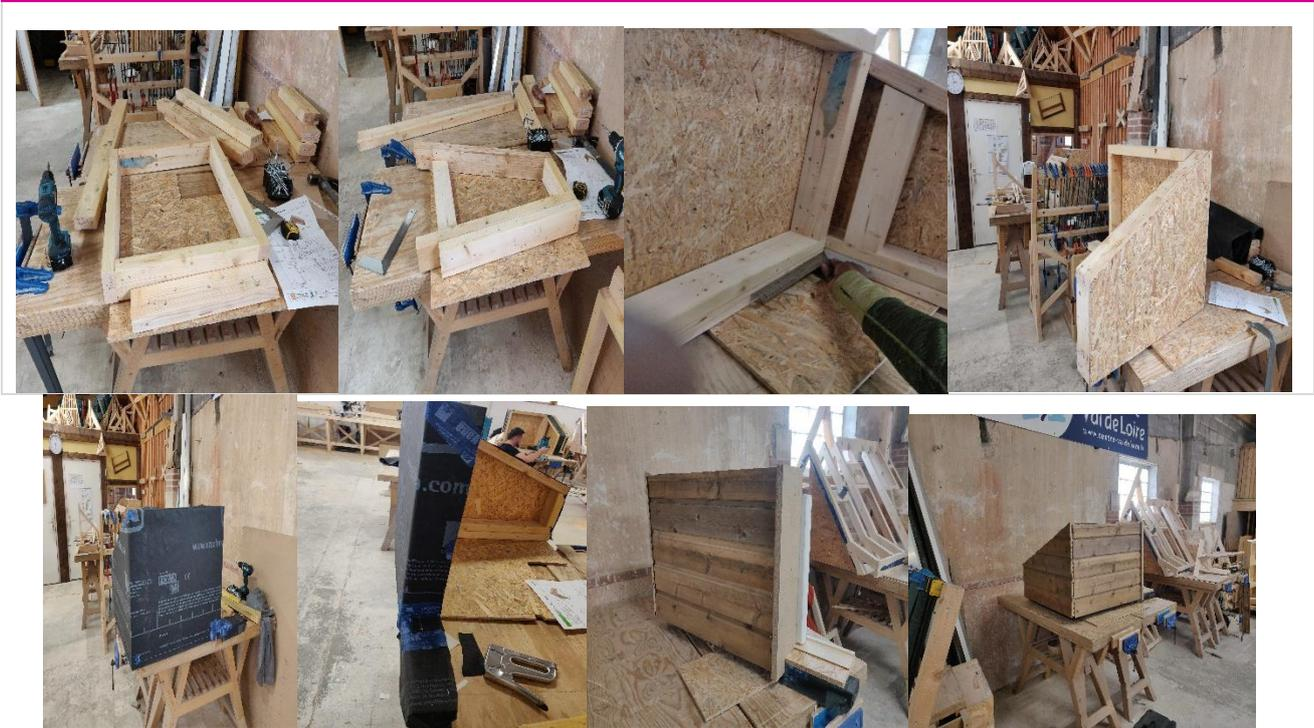
Construction d'angle de murs liaison en lisse basse, pare pluie, lattage et bardage, traitement de la baie de porte.
