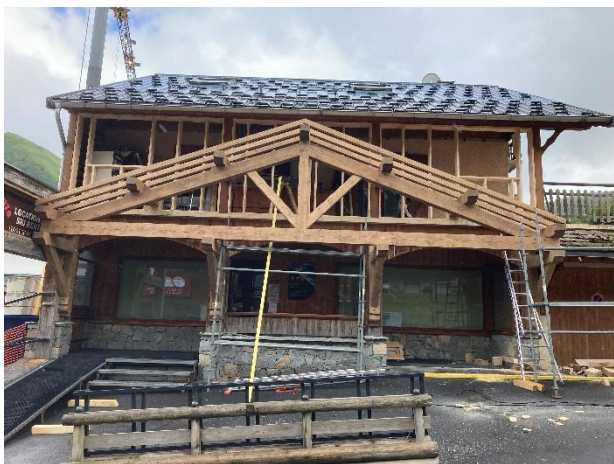
Extension à l'étage et avancée de toiture d'un magasin - Stage bac pro en Savoie
