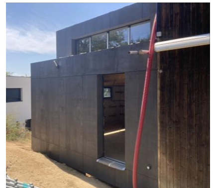
Chantier extensions OB 25m2 isolation laine de bois à Lyon – Façades viroc
