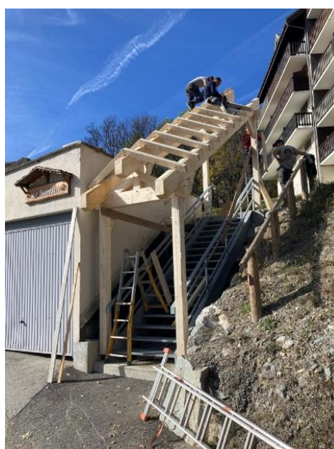
Abri pour escalier extérieur - Stage bac pro Savoie
