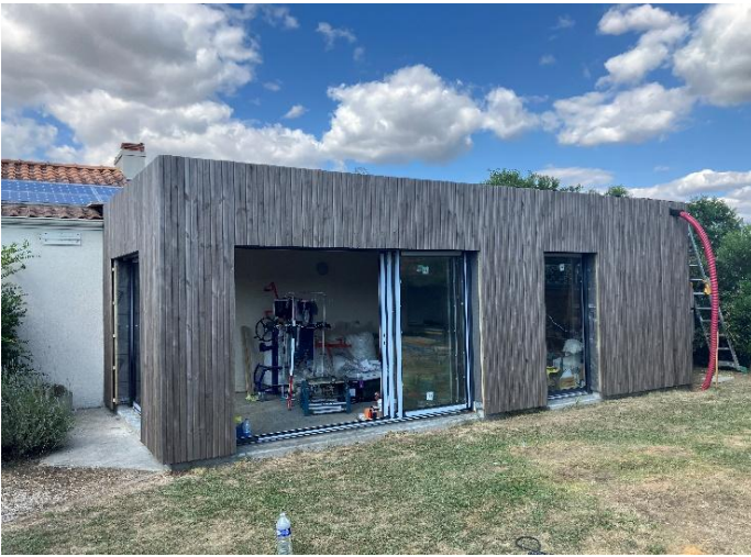
Chantier Nantes Extension en OB, bardage, toit terrasse 36m2
