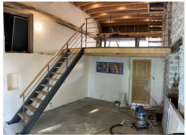
Conception et fabrication d'un escalier bois et métal pour mon cousin - Projet perso – conception sur cadwork à Nantes, Fabrication à Lille sur les weekends et pose de l'escalier dans le Morvan sur 3 jours.
