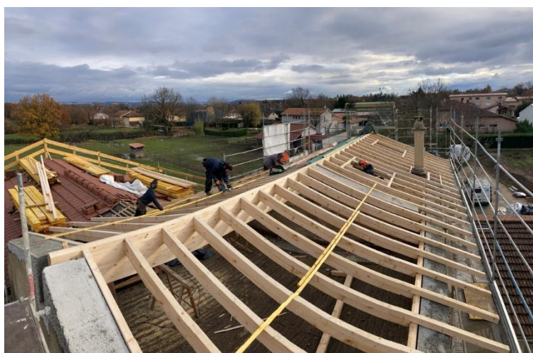
Chantier à Lyon charpente 2 pans et couverture (tuile 150m2)
