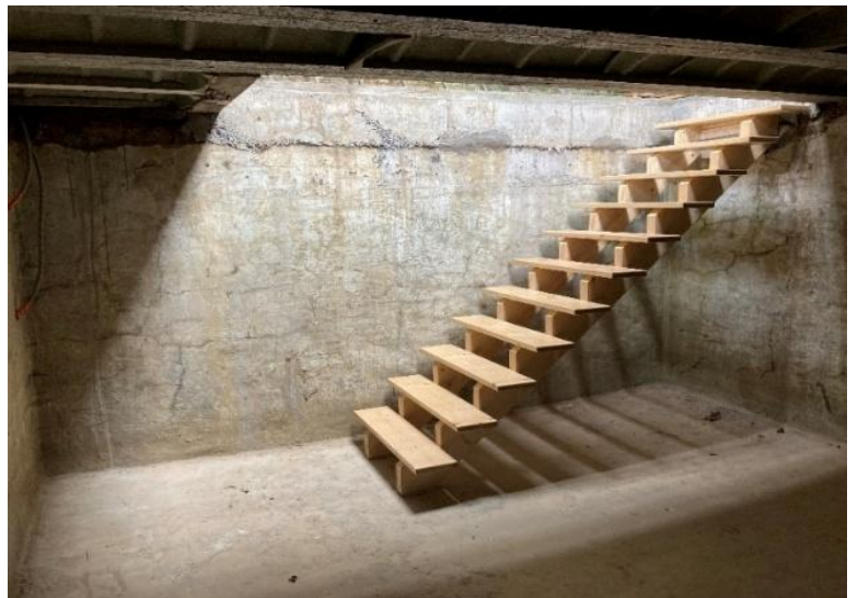
Escalier fabrication en 3 jours - Projet perso
