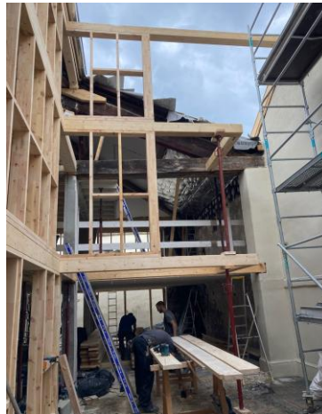
Chantier Ossature Bois sur 3 étages à Lyon
