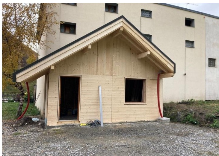
Fabrication d'un petit studio avec mezzanine - Stage bac pro Savoie
